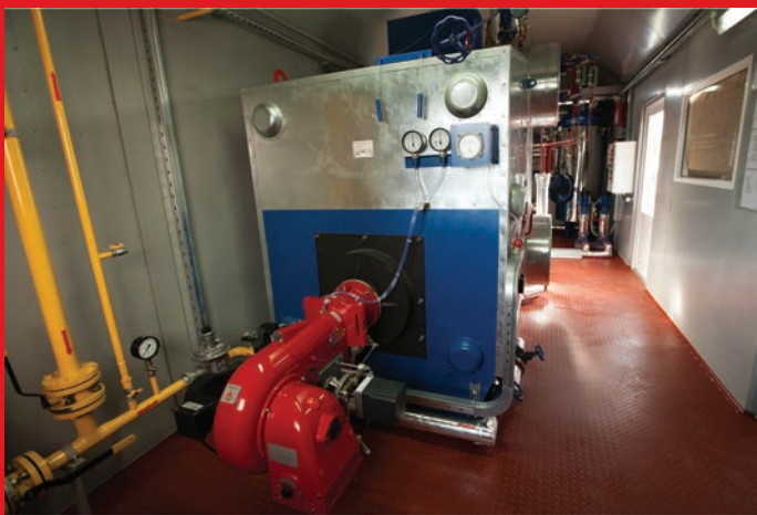
Модульна транспортовальна котельна установка МТКУ-0,7 з паровим котлом Е-1,0-0,9 (агропромислове підприємство, Полтавська обл.)
