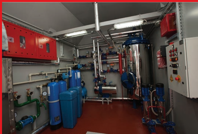
Деаераційна установка ДА-1 з щитом керування та установкою пом'якшення (агропромислове підприємство, Івано-Франківська обл.)
