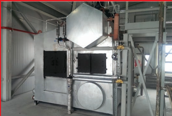
Котел паровий Е-1,8-0,9Р з виносною топкою ТВ для спалювання пелети (лікоро-горілчаний завод, Харківська обл.)
