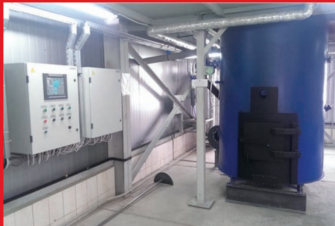
Котел паровий Е-1,8-0,9Р з виносною топкою ТВ для спалювання пелети (лікоро-горілчаний завод, Харківська обл.)
